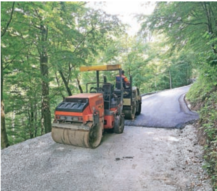
V rekonstrukcijo kilometra lokalne ceste Šurk–Ravne, ki so jo ta teden asfaltirali, bo občina vložila 137 tisoč evrov. / Foto: Andrej Tarfila
