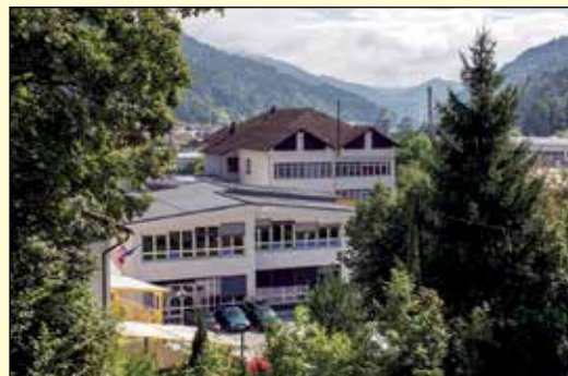
Detajl stavbe Osnovne šole Železniki. Foto: Andrej Tarfila
