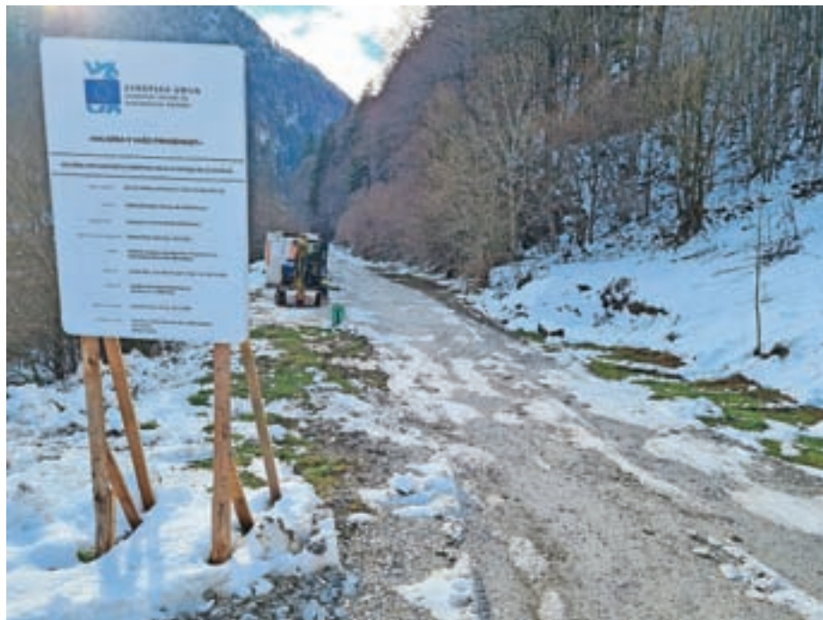
V občinskem proračunu za prihodnje leto je tudi precej denarja za dokončanje kolesarske povezave Železniki–Selca.
