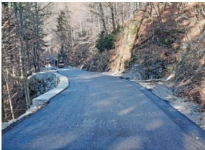
Tik pred prvim snegom je izvajalcem uspelo asfaltirati še dobrih 600 metrov dolg odsek ceste med Zgornjimi Danjami in Rotkom.
